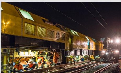
Renouvellement de rails à l'aide du train BOA
